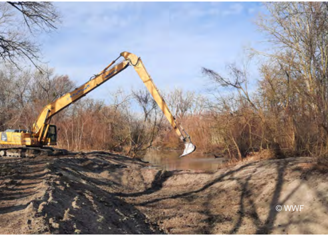
Braț al râului Vojčianske din Slovacia, o componentă esențială a sistemului deltei interioare a Dunării, atât înainte, cât și după lucrările de refacere, prin excavarea a 900 de metri de albie nouă a râului și readucerea apei în peisaj.
