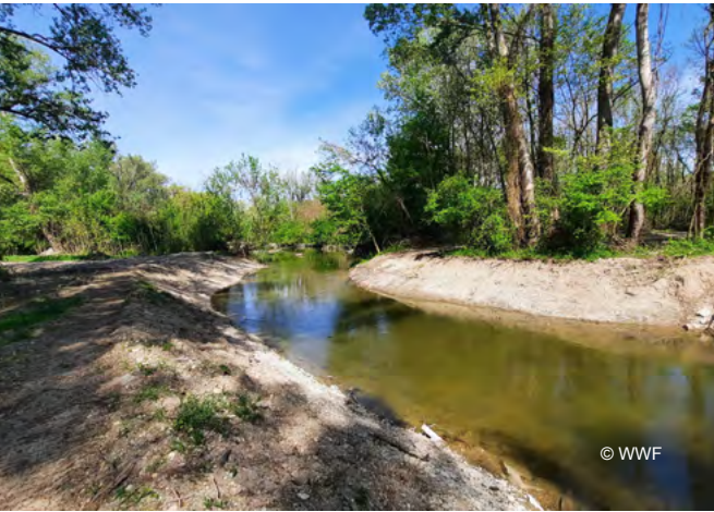
Braț al râului Vojčianske din Slovacia, o componentă esențială a sistemului deltei interioare a Dunării, atât înainte, cât și după lucrările de refacere, prin excavarea a 900 de metri de albie nouă a râului și readucerea apei în peisaj.
