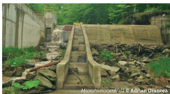
Microhidrocentrală © Adrian Grancea
