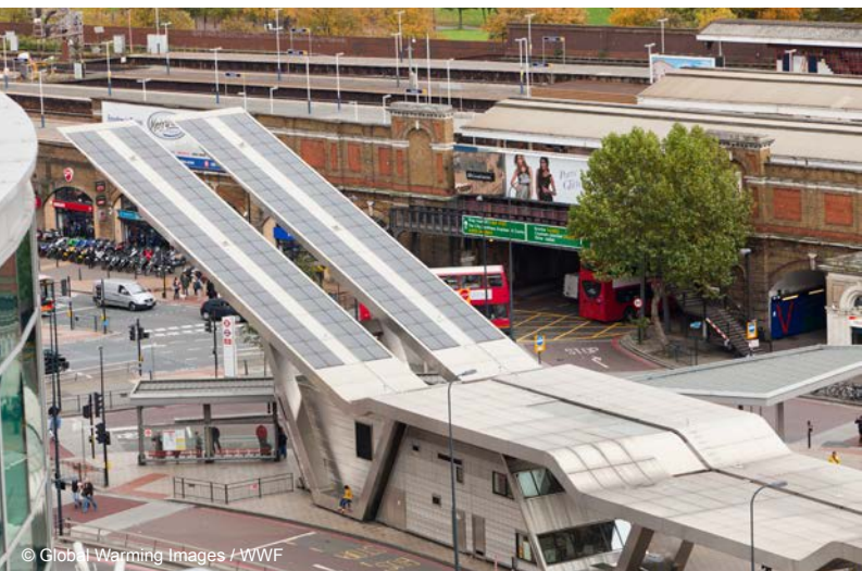
Stația de autobuz Vauxhall din Londra, Marea Britanie, prezintă panouri solare montate pe acoperiș care asigură o treime din necesitățile energetice ale stației de autobuz și ajută la reducerea emisiilor de dioxid de carbon.
